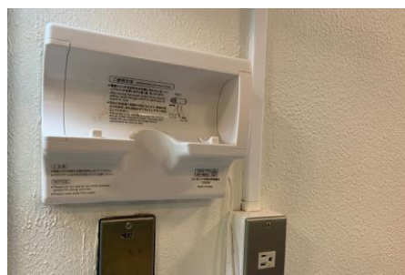
【ドライヤーの撤去】
