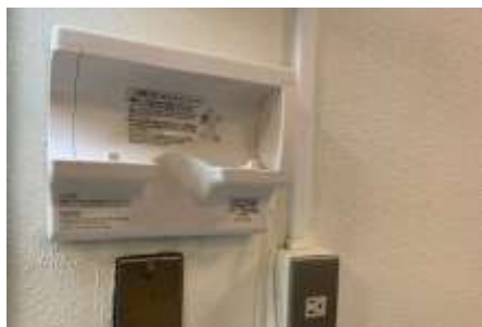
【ドライヤーの撤去】
