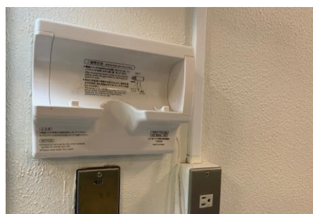
【ドライヤーの撤去】
