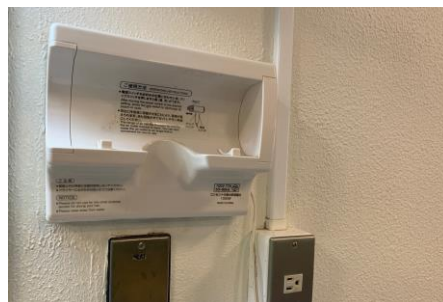
【ドライヤーの撤去】
